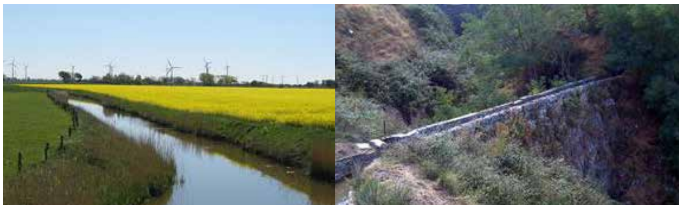
Figure 8. Deux exemples très différents de fossés en Allemagne (à gauche) et en Espagne (à droite). Celui à gauche est fait de matériaux naturels et présente des pentes douces. A l'inverse, celui de droite est fait de briques et présente des pentes à 90°. Source : à gauche, Dirk Ingo Franke (CC BY-SA 3.0) ; à droite, Javier Martin.
