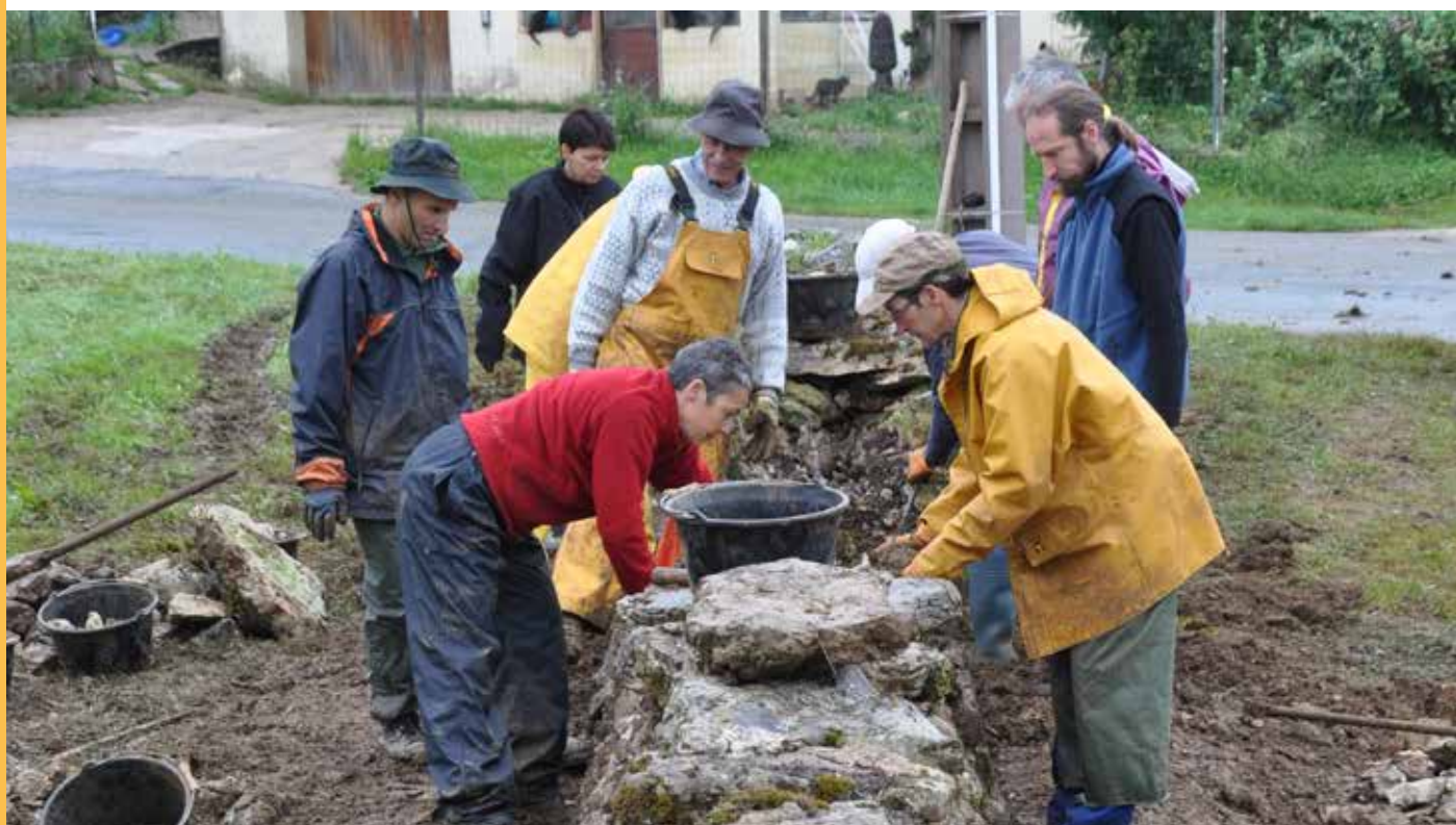
Figure 6. Création d'un mur de pierre à double rangée. France. Poncetdespontets (CC BY-SA 4.0).
