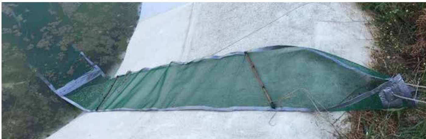
Figura 4. Raccolte d'acqua ottenute con scavi ripidi e impermeabilizzati con materiali sintetici, costituiscono un rischio per molti animali che vi entrano e non trovano modo di venirne fuori. Qui una via d'uscita di rimedio. Catalogna, Spagna. Fonte: Ander Achotegui. ( Fundació Emys ).
